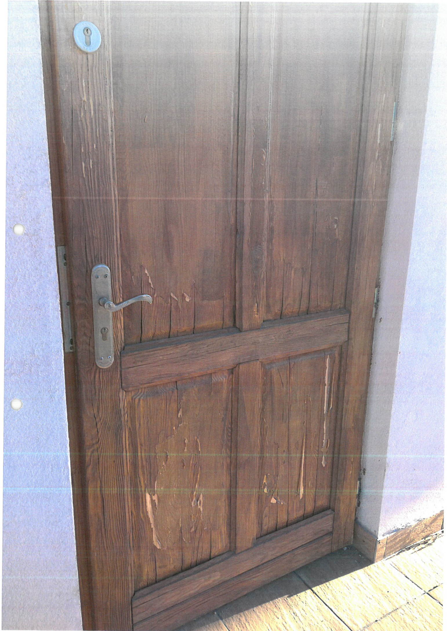
DRZWI OD STRONY POŁUDNIOWEJ
