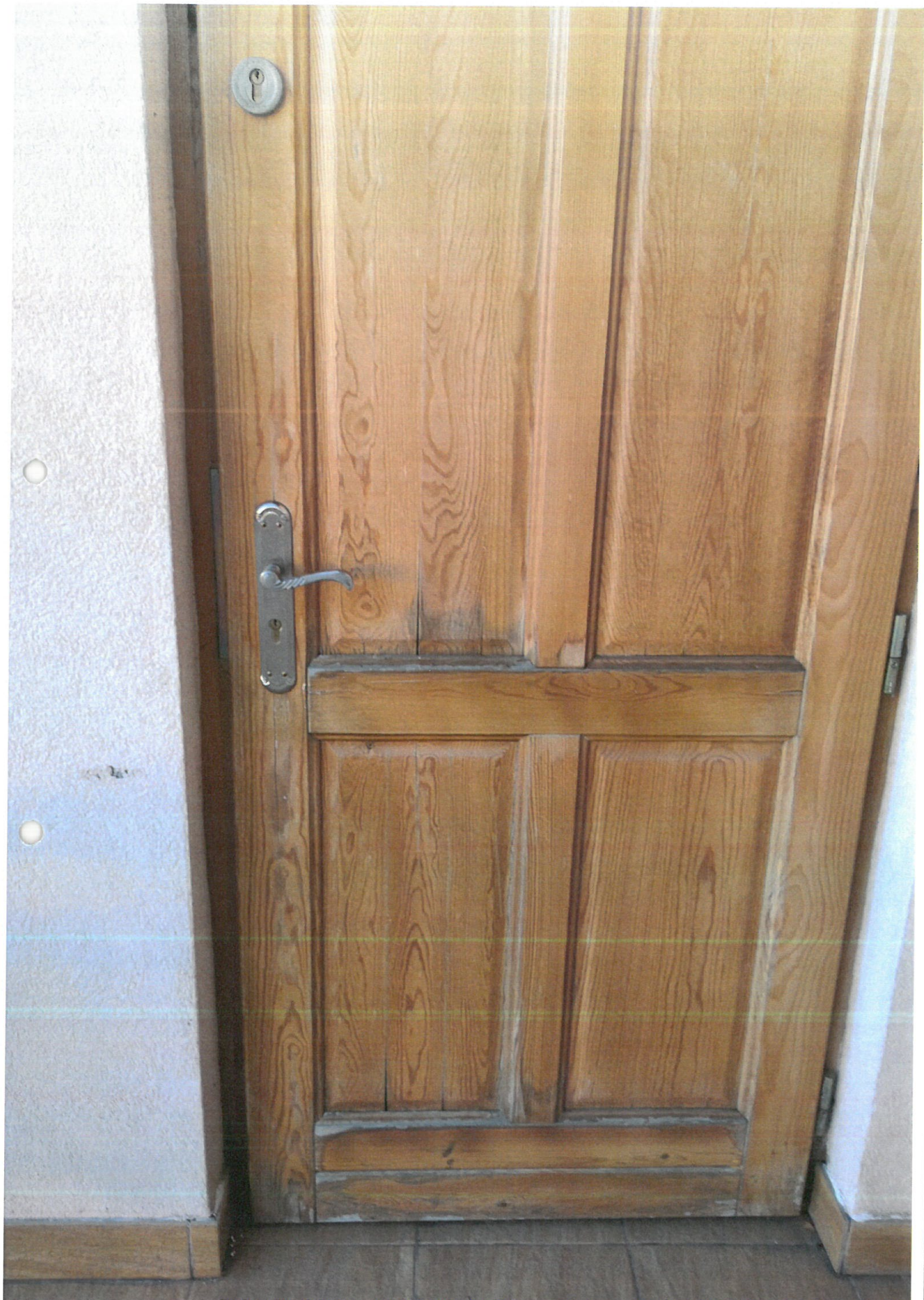
DRZWI PRZY PODJEZDZIE DLA NIEPEŁNOSPRAWNYCH 21
